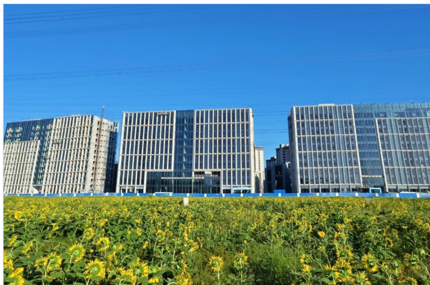
现阶段科创楼实景图 拍摄于2024年11月
